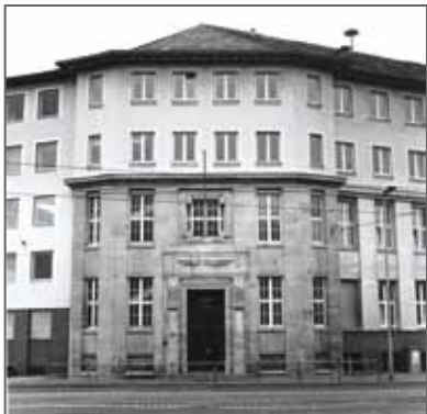
Das ehemalige Gebäude (Binger Straße 26)
